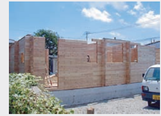
国の防火認定も得ている厚さ10cmのムク材の丈夫な壁材。外装と内装が一度にできます。
