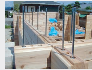
ボルトに通して積み上げていきます。レゴブロックの要領ですね。
